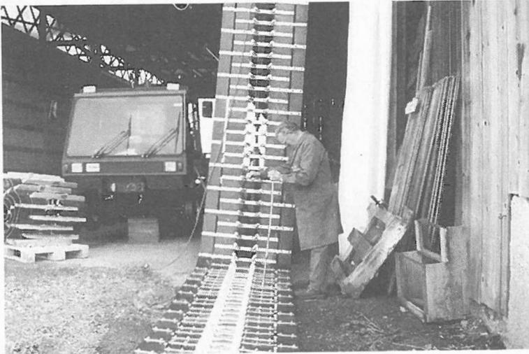
Grosse Arbeit gaben die Raupen, wo er viele gerissene Teile auswechselte und lose Schrauben neu sicherte. Auch die Laufräder wurden mitsamt den Lagern entfernt, gereinigt, neu gefettet und alles säuberlich wieder zusammengebaut.
